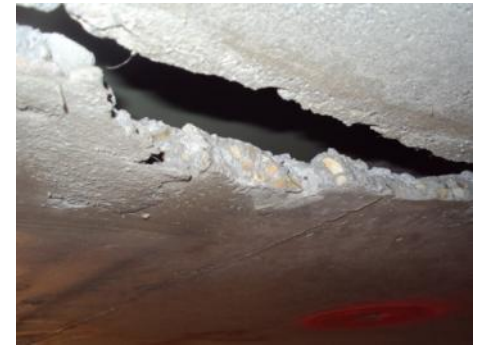
DEFECTOS DE LLENADO DE MODULOS DE ENCOFRADO EN LAS JUNTAS ENTRE ANILLOS SECCIONES DEL REVESTIMIENTO (CLAVE DEL TUNEL)
