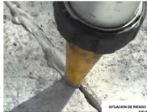
SITUACION DE RIESGO DERIVADA DE LA COMBINACION DE UNA JUNTA FRIA Y UNA FISURA DE RETRACCION QUE LA ALCANCE
