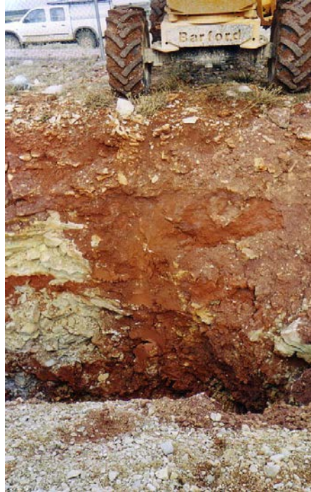
1. Levantamiento de la cuneta y saneo cavidad
