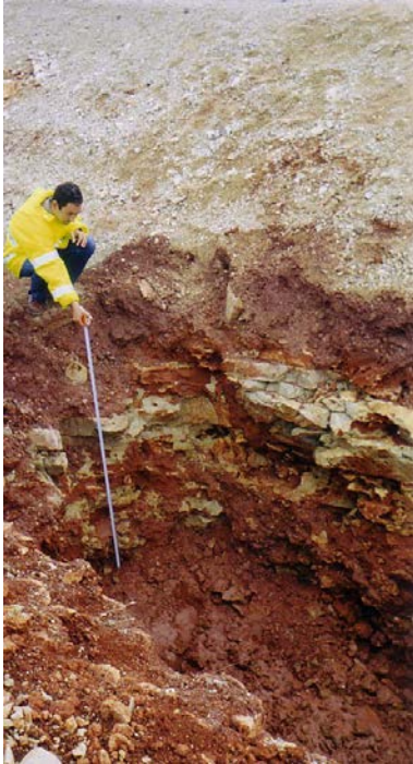
1. Levantamiento de la cuneta y saneo cavidad
