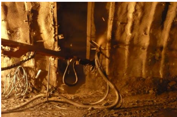
FIGURA 7. Proyección de hormigón
