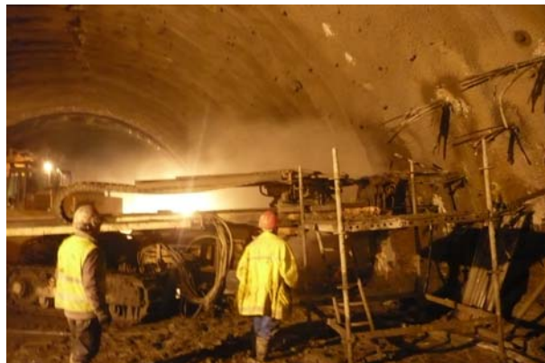
FIGURA 8. Perforación de anclajes
