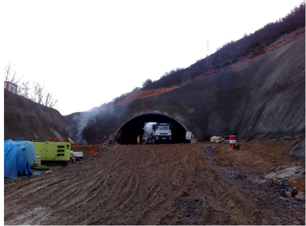
FIGURA 9. Vista del emboquille en el p.k 9+180.
