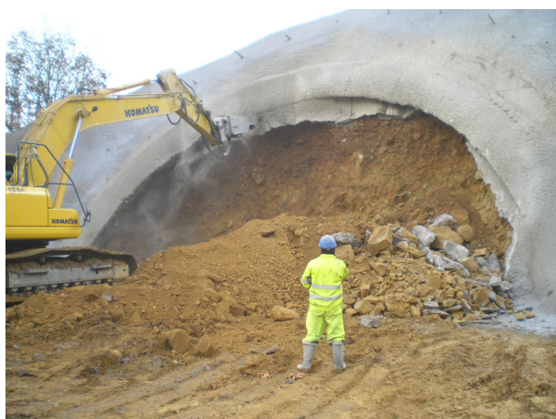
FIGURA 12. Inicio de la excavación del túnel en mina.
