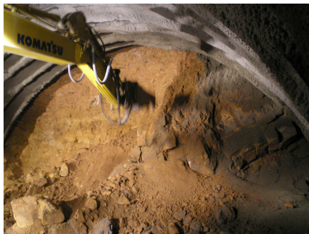
FIGURA 13. Disposición típica de terrenos en el frente de avance.
