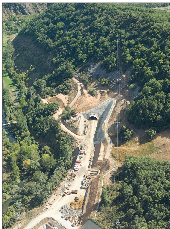
FIGURA 21. Vista general del emboquille norte del túnel de Nocedo
