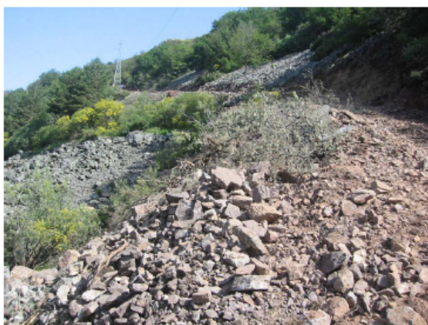
FIGURA 2. Vista del canchal incluida en el proyecto
